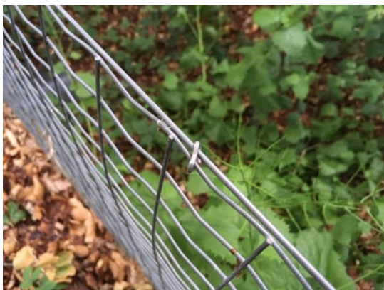
Bevestiging stalen bovendraad met varkenskrul
